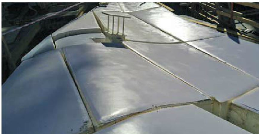
חלקי תבניות היציקה העשויות פולימר מיוחד שיוצרו בהדפסה תלת-מימדית עבור קימרון גג מבנה ההיכל
