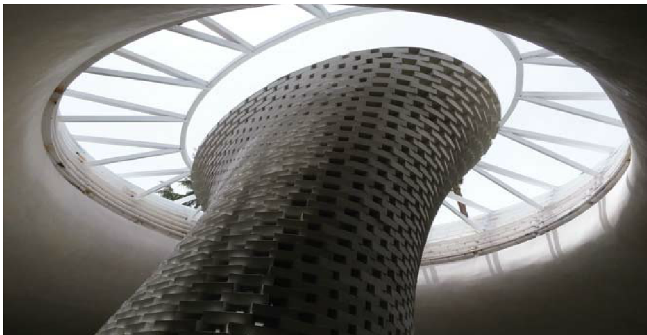
מבנה "פעמון האור" שבמרכז היכל הזיכרון לאחר השלמתו כשמעליו הקורות המיועדות לנשיאת הסקיליט
